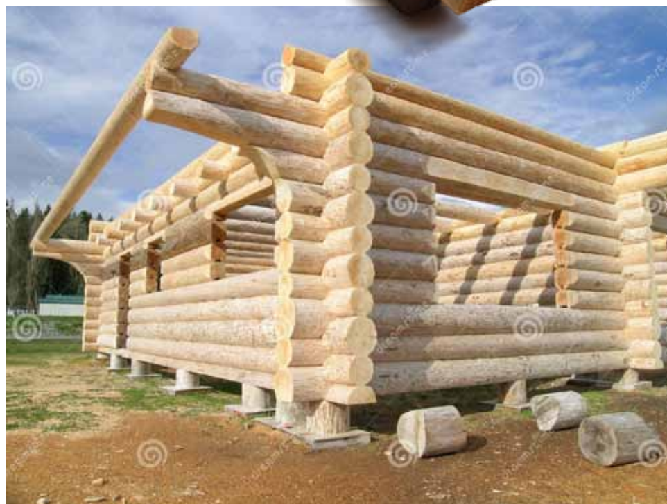
Kanadský srubový sedlový spoj
