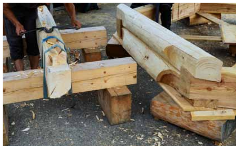
Výroba podélné drážky v prizmě
