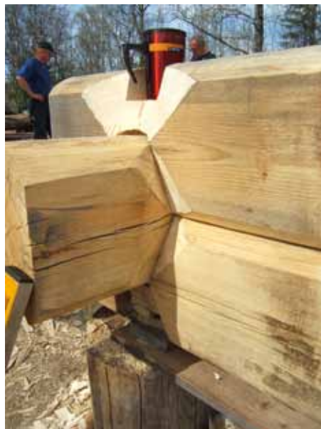
Nebezpečná výsušná trhlina
