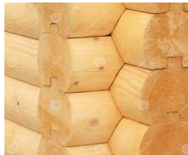
Strojně vyfrézované podélné napojení klád
