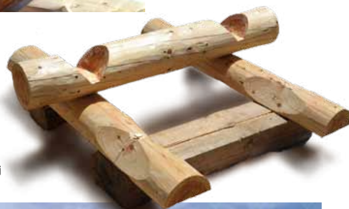
Kanadský srubový sedlový spoj
