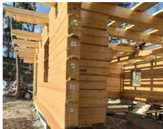
Dosed stěny s podélnými drážkami v prizmách
