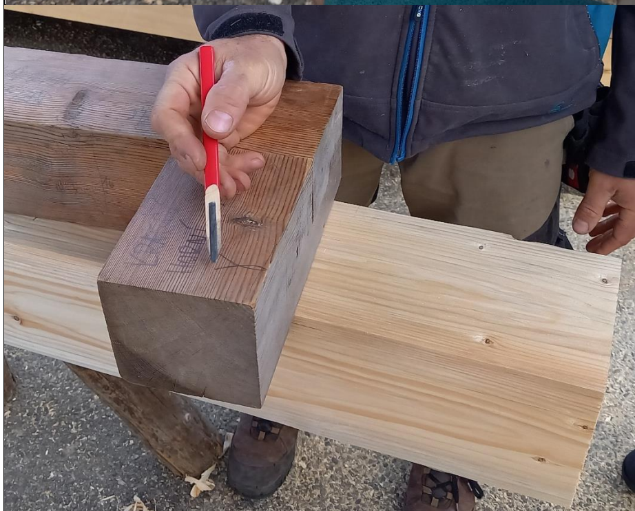
Detail spoje, označení lícových (vnějších pohledových) stran rohu trámu.
