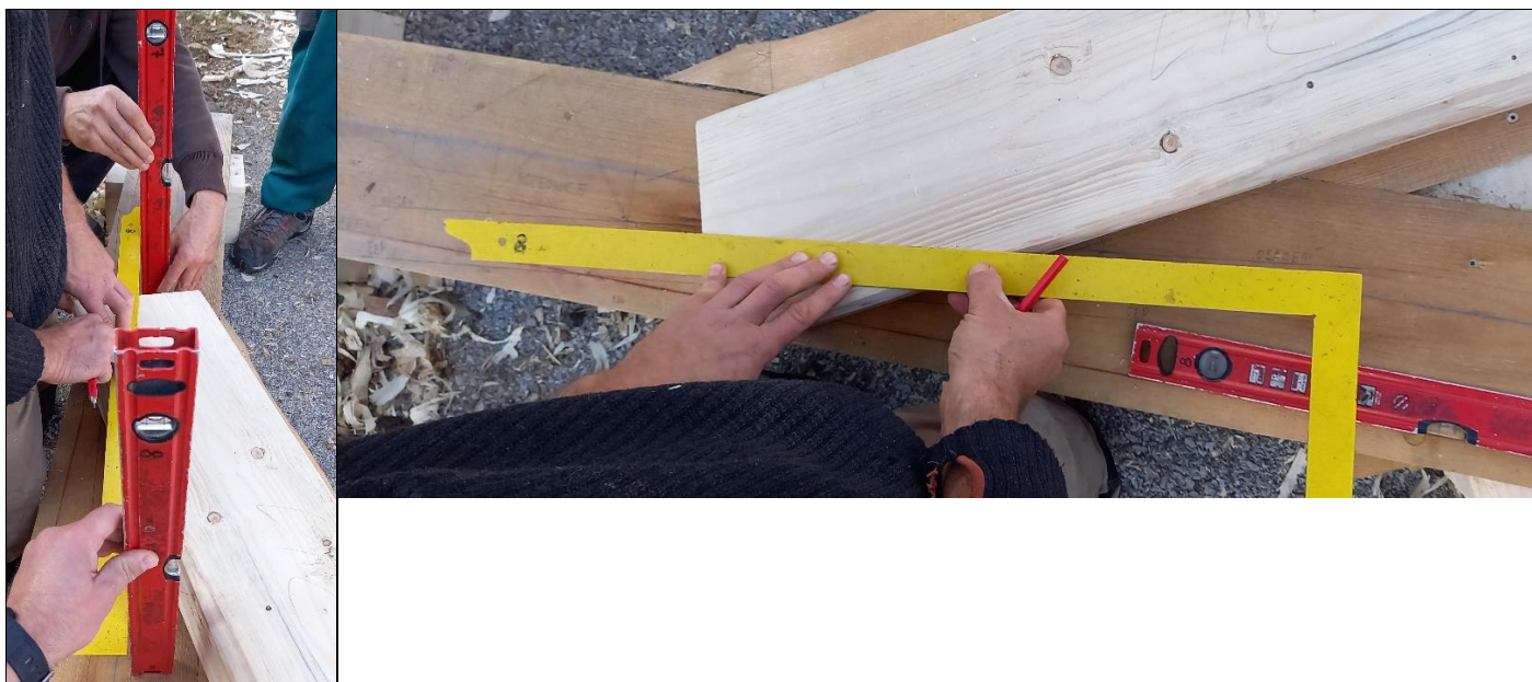
Během všech přenášení čar je nutné dbát na kolmost a rovnoběžnost se šablonou.
