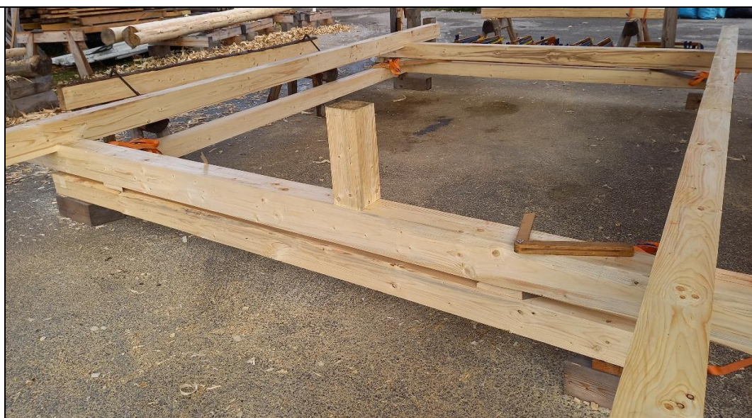
Vyrovnání základový a střešní lemu. Pomocí vodováhy zjistíme pozici, kde budeme vytvářet lůžko pro spoj trámů střešního lemu.
