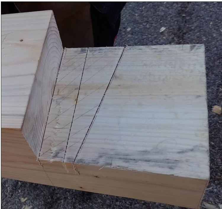
Předříznutí dlabané části rybinového spoje na více místech
