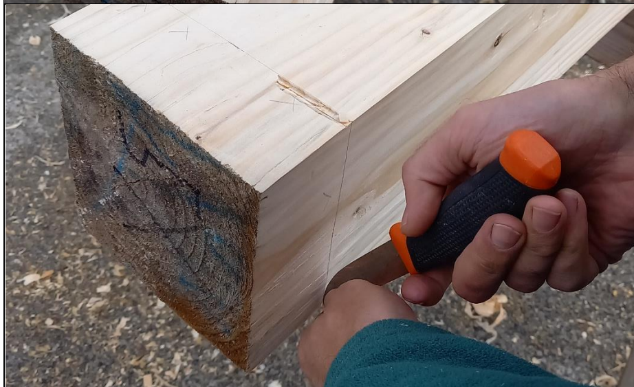
Oříznutí hrany čepu nožem, aby při se dřevo při dlabání neodštípávalo.
