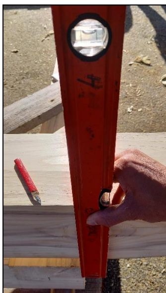
Vyrovnání základový a střešní lemu. Pomocí vodováhy zjistíme pozici, kde budeme vytvářet lůžko pro spoj trámů střešního lemu.
